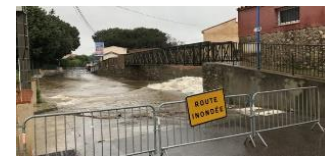
Sécurisation passage à gué
